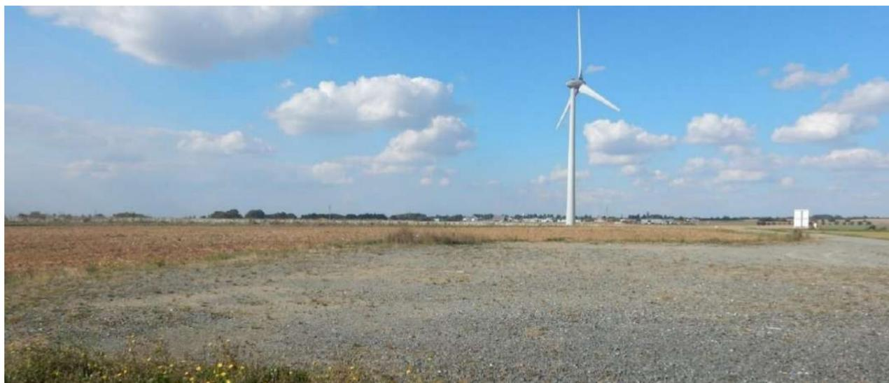
Photo 249 : Exemple de plateforme depuis le pied d'une éolienne
