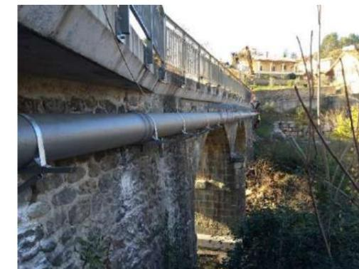
Figure 165 : Exemple d'encorbellement (Source: Rampa-tp.com)
