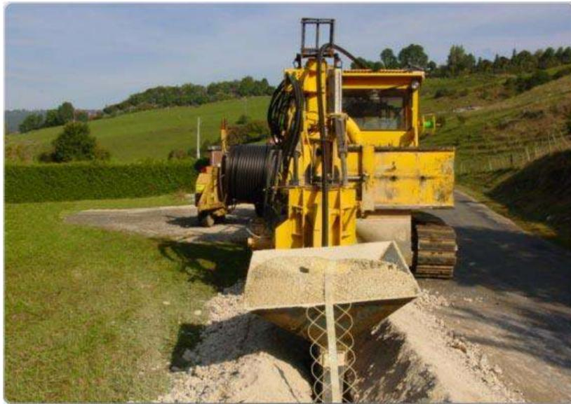
Photo 253 : La pose d'un câble souterrain depuis le poste de livraison jusqu'au réseau électrique public
