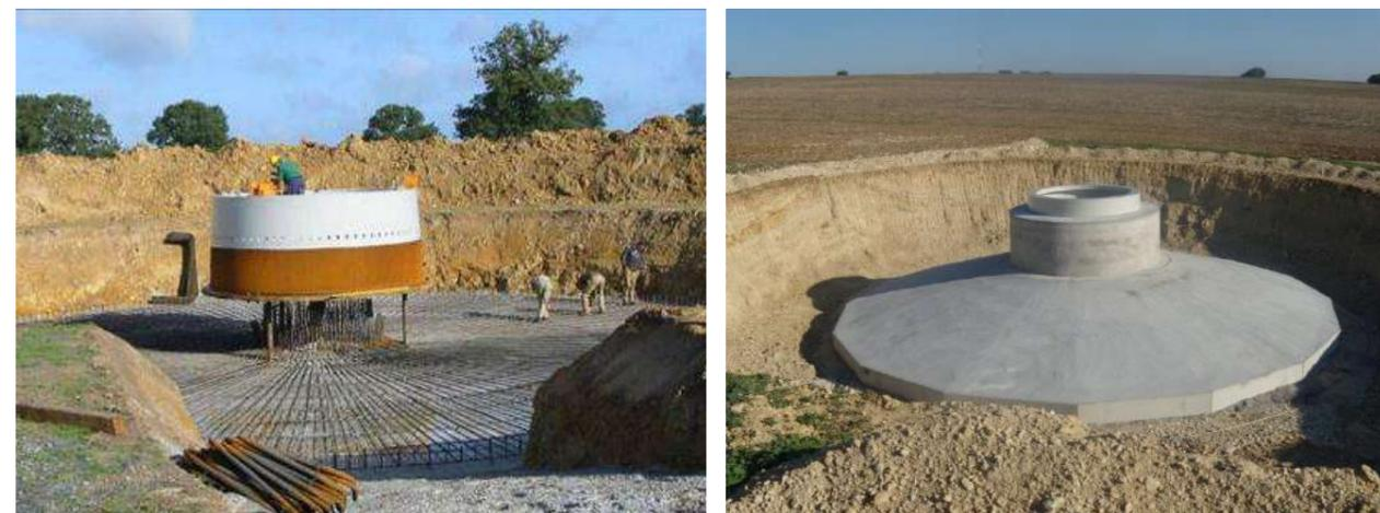
Photo 248 : Le coulage d'une fondation d'éolienne
